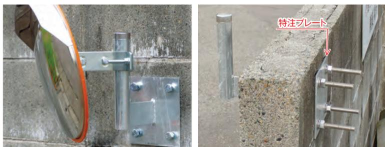
**特長** アンカーボルトを打ち込み、金具を取付けます。中空のブロックのようにアンカーが効かない場合は特注プレートを用いて貫通ボルトで挟みこみます。その際は別注のあて板が必要となります。ALC壁の場合はALCアンカーを用いて固定します。ホームミラーであれば、一面、二面問わず全サイズ取付可能です。
