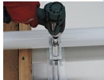
⑦ 工具で締め付けて固定します。
