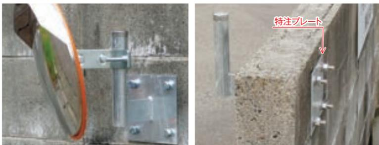
**特長** アンカーボルトを打ち込み、金具を取付けます。中空のブロックのようにアンカーが効かない場合は特注プレートを用いて貫通ボルトで挟みこみます。その際は別注のあて板が必要となります。ホームミラーであれば、一面、二面問わず全サイズ取付可能です。
