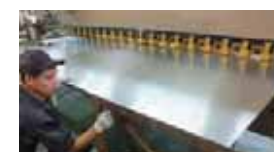
標識板製作工程 17
