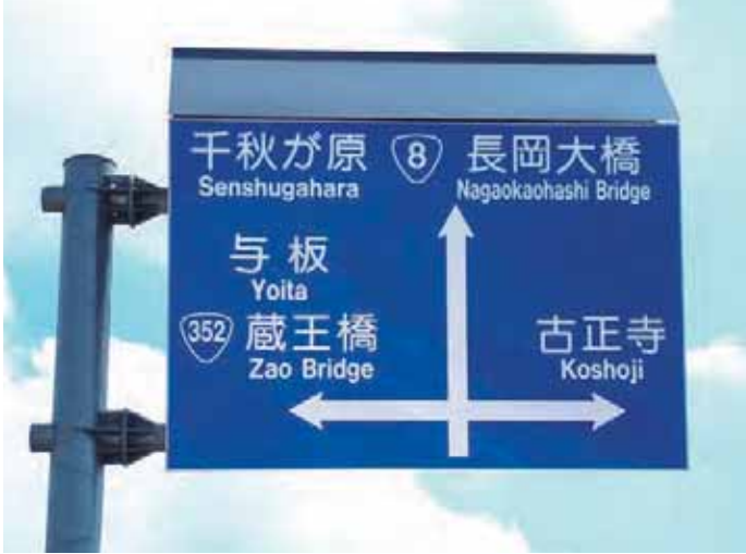
着雪防止板…降雪時に標識板の裏面に雪だまりを防止する板
